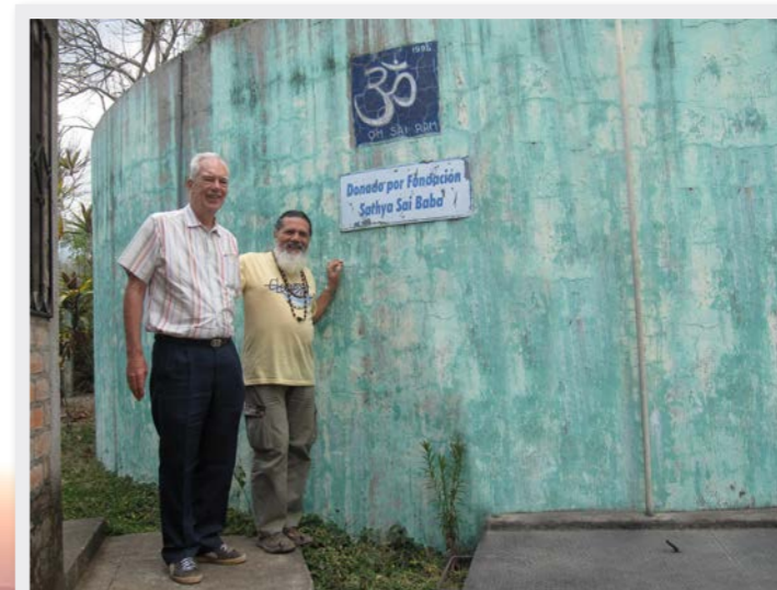
Questo enorme serbatoio d'acqua, costruito nel 1996, continua a servire oltre 1000 case in una comunità. È uno dei 12 Progetti Idrici avviati dalla Fondazione Sai dell'El Salvador.
